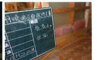
圧縮グラスウールによる気流止めと金物補強
