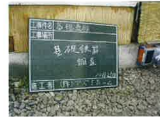
基礎鉄筋調査～鉄筋探査機で調査⇒有筋を確認
