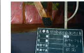
圧縮グラスウールによる気流止めと金物補強
