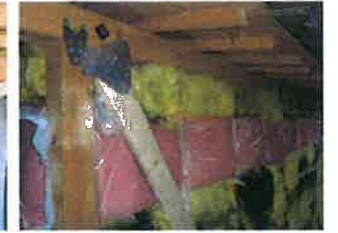
外装張替え工事・桁廻りの金物補強と気流止めグラス
