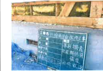
事前調査～土台廻りの金物・断熱材等のチェック
