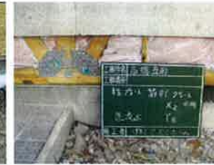
断熱耐震同時施工～気流止め+既存筋交いに金物取り付け
