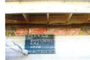
桁廻りの断熱耐震同時施工～気流止め&補強金物
